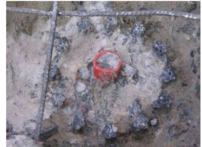
Vue de dessus d'une tête de câble + coulis d'injection (contrôle
