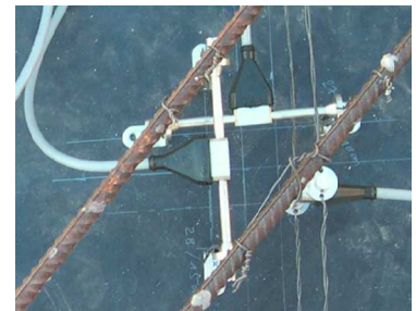
Des extensomètres accrochés aux armatures avant le coulage du béton
